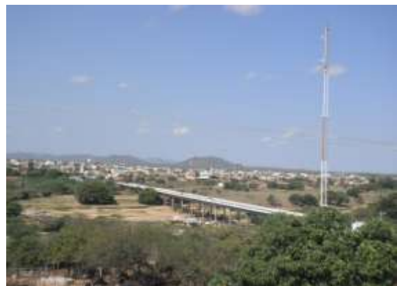
Figura 02: Ponte sobre o rio Piranhas nos dias atuais. Fonte: Maria Sandra Almeida Santos. Agosto de 2011.
