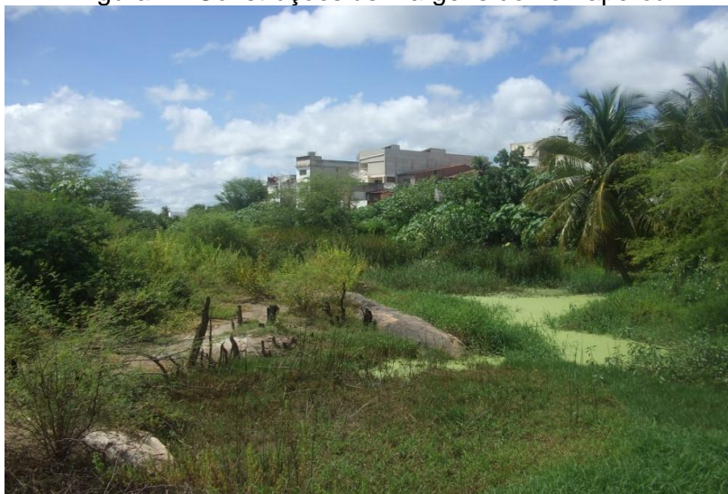
Figura 7 - Construções às margens do rio Taperoá
