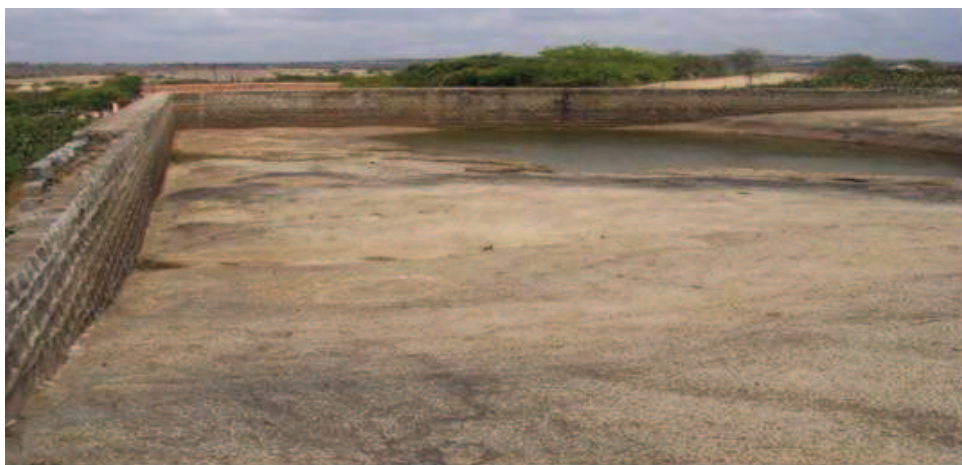
Figura 17. Tanque de Pedra natural, cercado por paredes de concreto. Sítio Pedra Redonda, Pocinhos, PB, dezembro de 2009.
