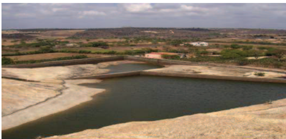
Figura 16. Tanque de Pedra natural, com intervenção de paredes de concreto, com divisão de um para outro. Sítio Pedra Redonda, Pocinhos, PB, janeiro de 2010.
