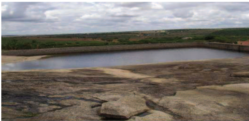
Figura 15. Tanque de Pedra natural, com uma parede de alvenaria para aumentar o volume armazenado. Sítio Pedra Redonda, Pocinhos, PB, janeiro de 2010.
