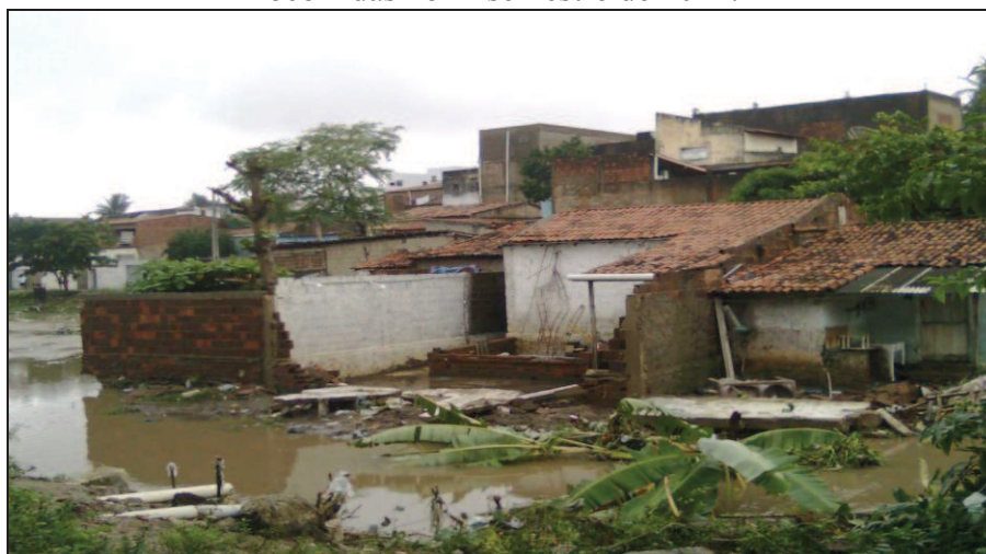
Figura 03 – Casas construídas no curso do Canal das Piabas e derrubadas pelas chuvas ocorridas no 1º semestre de 2011.
