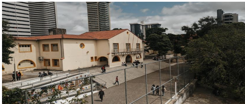
Figura 1: Edificação da ECIT. DR Elpídio de Almeida
