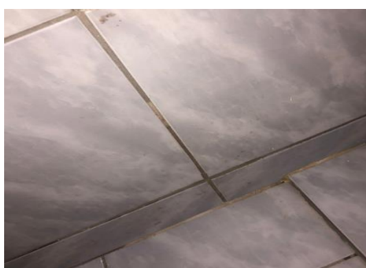
(h) rejunte do wc social
