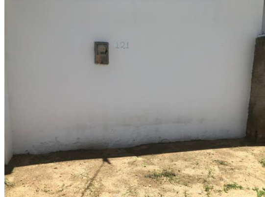
(b) Parede de divisa da garagem (lado externo)
