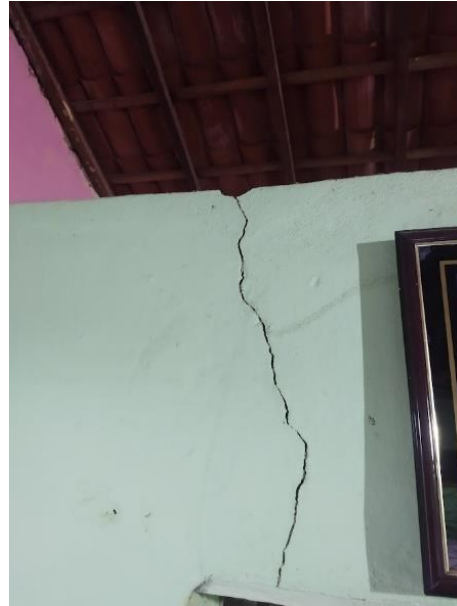
(e) Parede sala de estar
