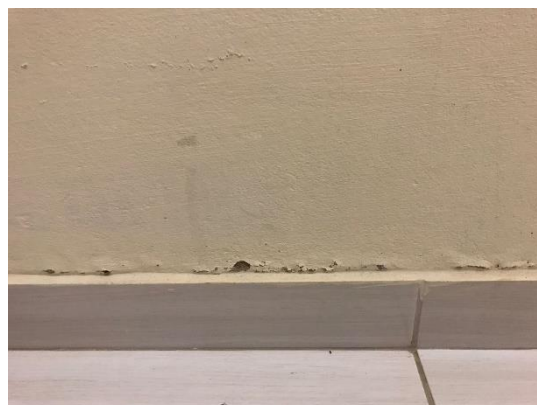
(b) Parede de divisa entre a sala com a parede da garagem (lado da garagem)
