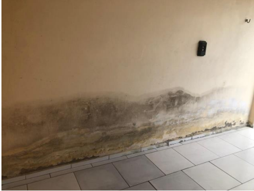
(a) Parede de divisa da garagem (lado interno)
