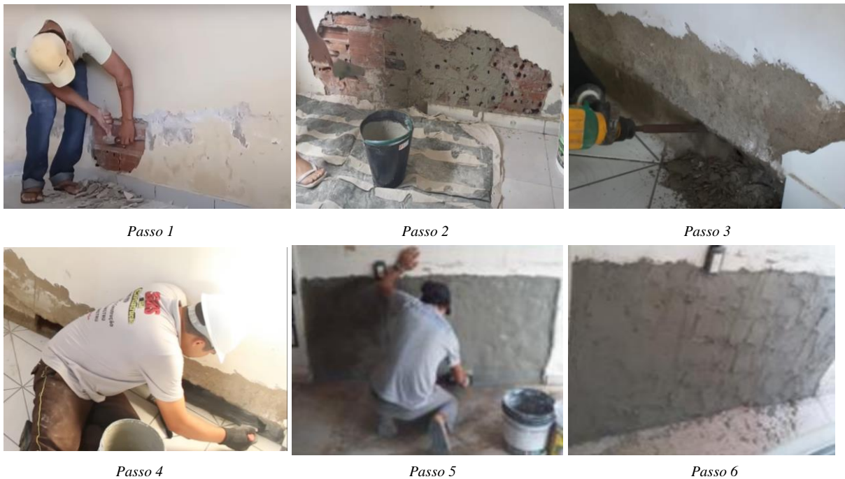
Figura 14: Reparação de infiltração
