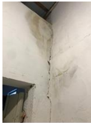
(b) Parede externa banheiro
