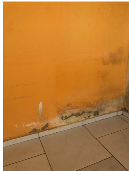
(d) Parede interna da garagem
