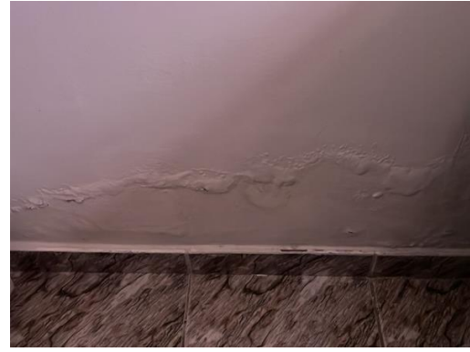
(b) Parede da área de serviço
