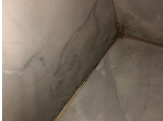
(b) Parede de divisa do quarto 02 wc social (lado do wc)
