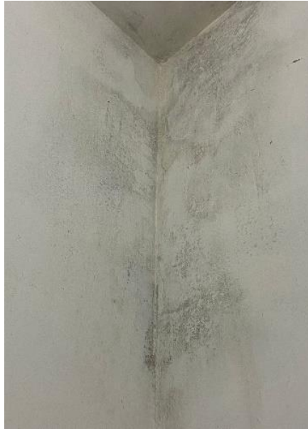
Figura 27: Parede quarto 01 em divisa com área externa e wc social
