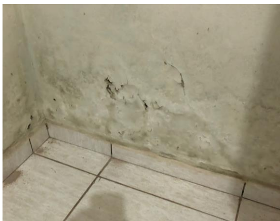
(a) Parede da cozinha com a outra face virada para o vizinho (sentido leste)
