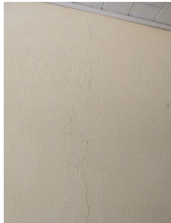
(d) Parede interna da garagem
