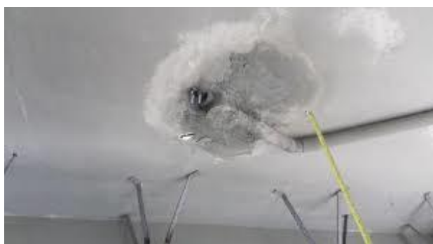
Figura 6: Umidade accidental
