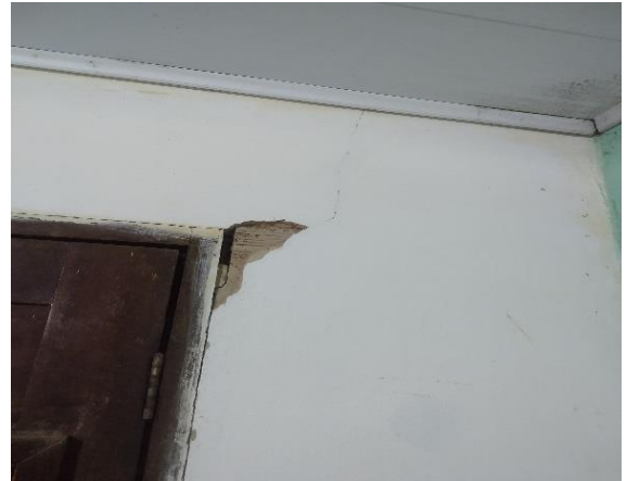
(b) Parede de divisa da cozinha (lado interno)
