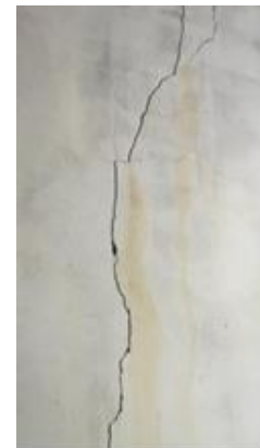
(f) Parede cozinha/banheiro
