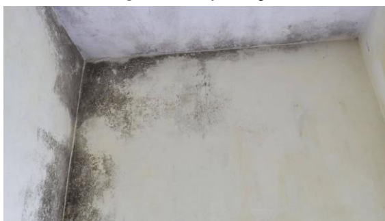
Figura 8: Infiltração
