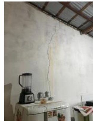
(c) Parede cozinha
