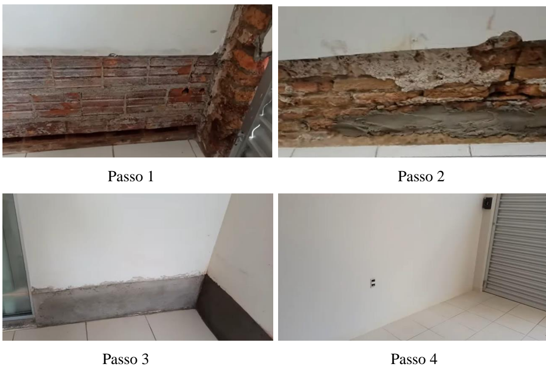
Figura 40: Reparação de infiltração
