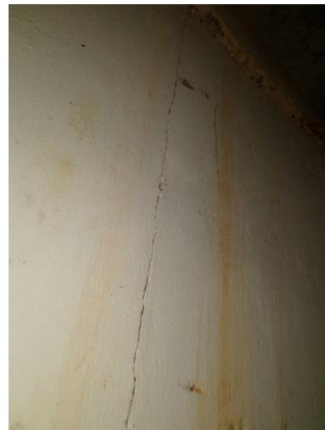
(g) Parede garagem
