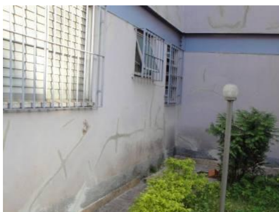
Figura 4: Umidade ascensional
