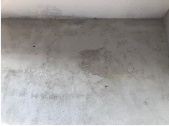
(a) Parede da garagem que faz divisa com parede do vizinho (vista superior)
