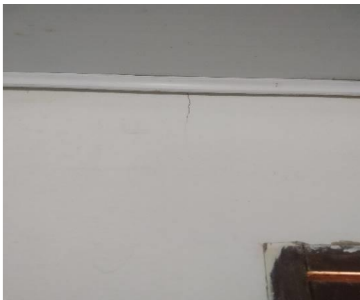
(a) Parede de divisa da cozinha (lado interno)
