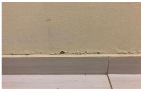
(e) Parede de divisa do quarto 02 com wc social (lado do quarto)
