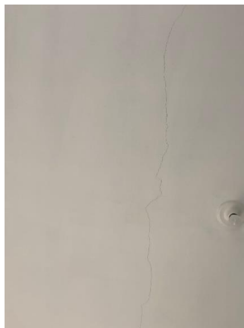
(a) Laje do quarto 02
