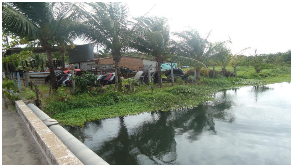
Figura 7: Construção irregular próximo ao rio Cuiá Fonte: Pesquisa de campo, 2013.
