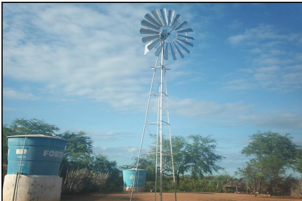
Figura 9 - reservatórios de água no assentamento Nova Vida I, Sousa/PB. Fonte: Pesquisa de Campo, imagem do autor, 05/2011.
