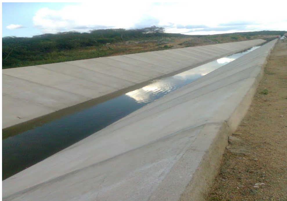
Figura 5 - Construção do canal da transposição do rio São Francisco, Monteiro/PB Fonte: Pesquisa de campo, imagem do autor, 05/2011.
