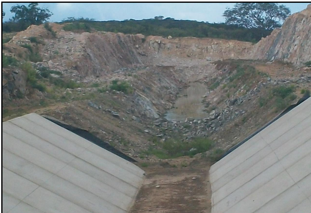
Figura 4 - Visão parcial da obra do projeto de transposição do rio São Francisco, Monteiro/PB. Fonte: Pesquisa de campo, imagem do autor, 05/2011.
