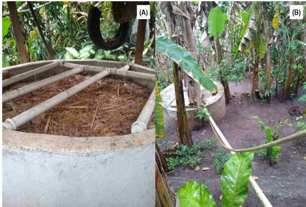
Figura 3 – Vista do filtro (A) e do tanque de reuso (B) do sistema Bioágua.
