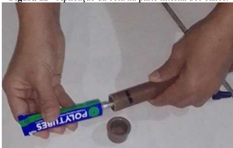
Figura 12 - Aplicação da cola na parte interna dos canos.
