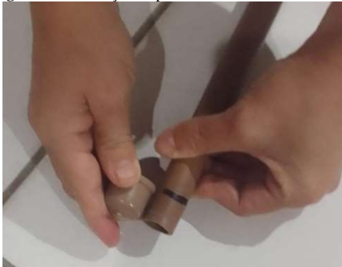
Figura 11 - Marcação da profundidade das extremidades.
