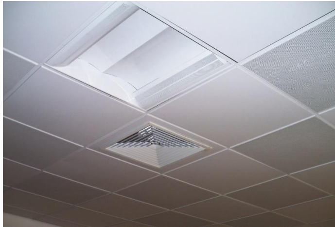
FIGURA 12: Iluminação e ventilação de ar – Depósito 2 FONTE: Dados da pesquisa (2010)
