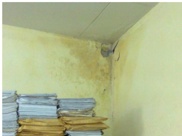
**FIGURA 10:** Mancha da infiltração
