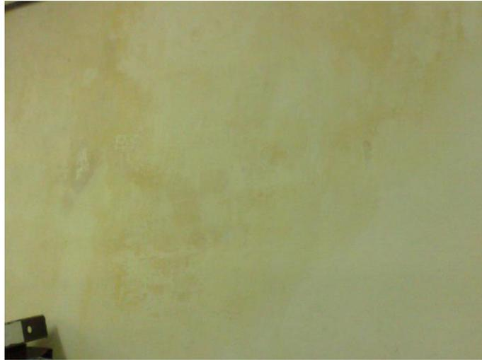
**FIGURA 11:** Mancha da infiltração
