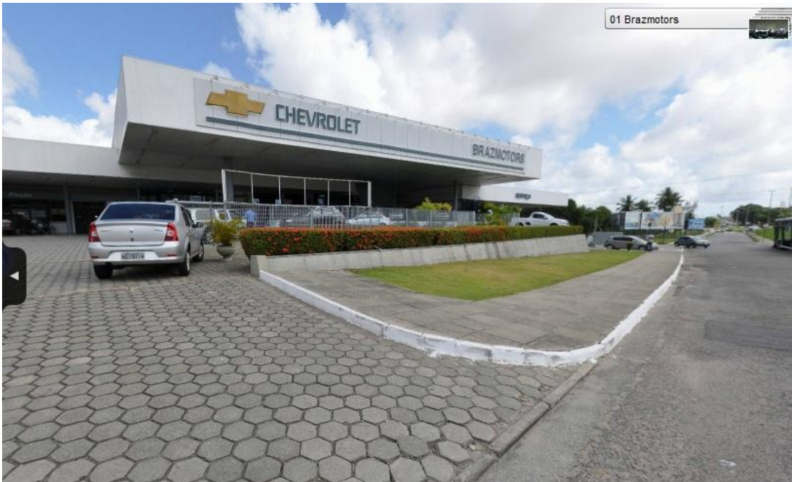
Fachada da empresa Brazmotors Veículos – João Pessoa
