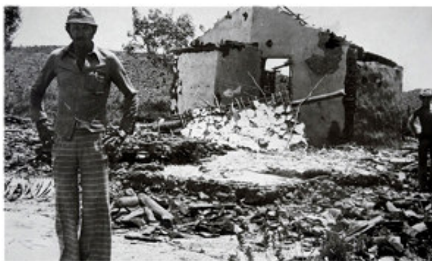
Manoel Correia em frente às ruínas da sua casa em 24.03.79
