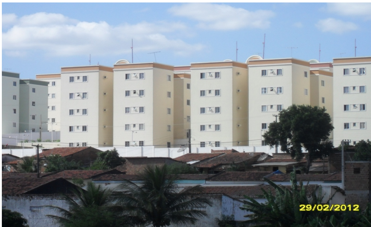
Figura: Condomínio João Paulo II - Bodocongo
