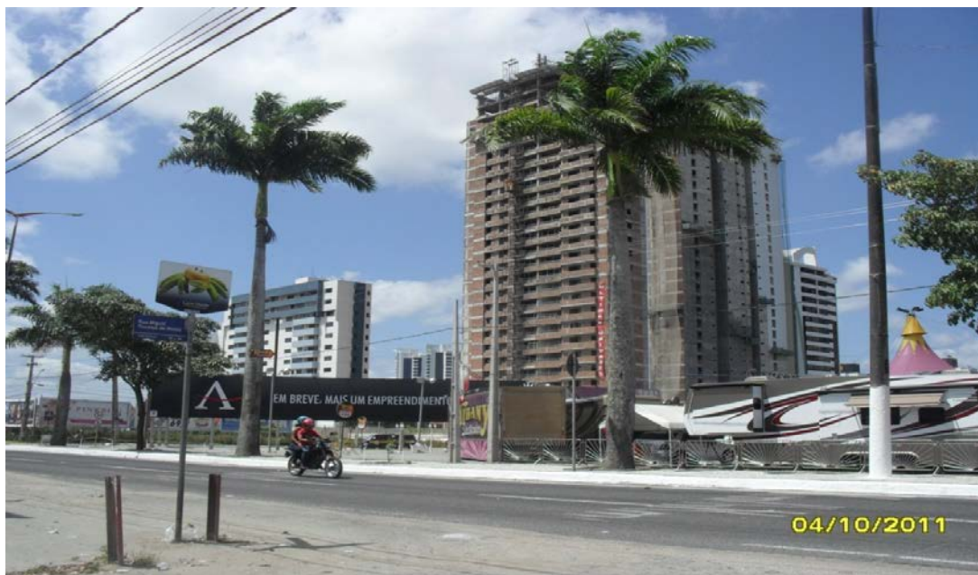
Figura 07 – Prédio em construção na Avenida Brasília
