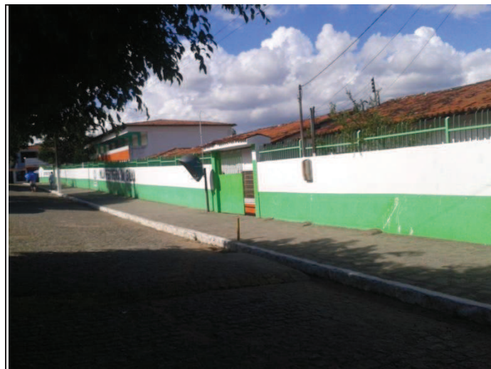
Foto 01: Fachada da Escola Municipal Nila Ferreira
