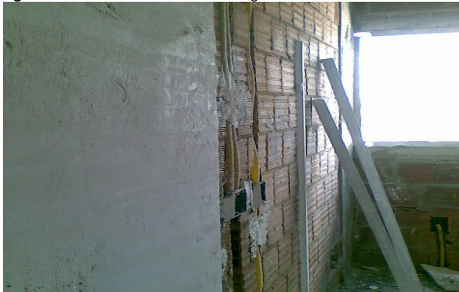
Figura 09. Mestras do revestimento em gesso.
