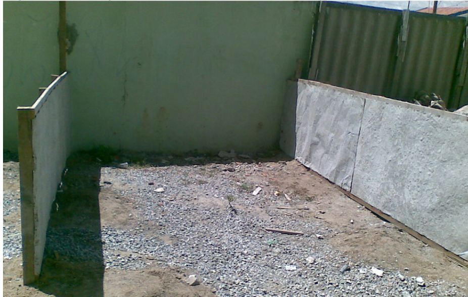
Figura 04. Baia para recebimento do resíduo de gesso.
