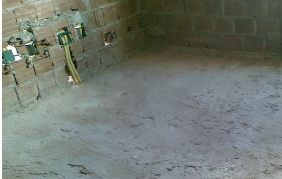
Figura 08. Serviço elétrico pronto, antes do serviço de gesso.
