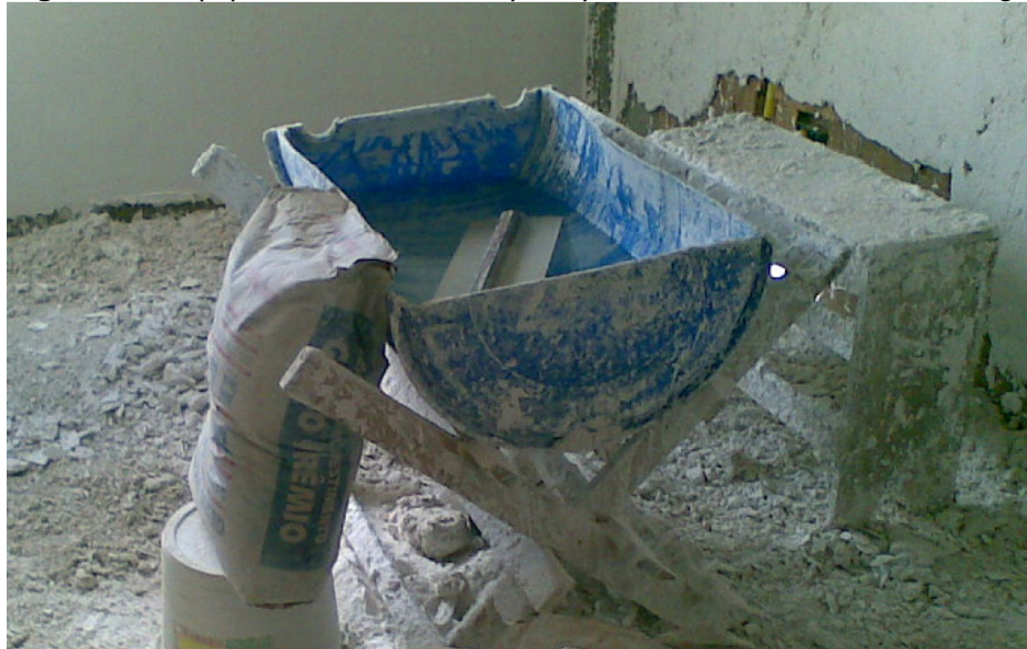
Figura 02. Equipamento e material para processo de revestimento de gesso.
