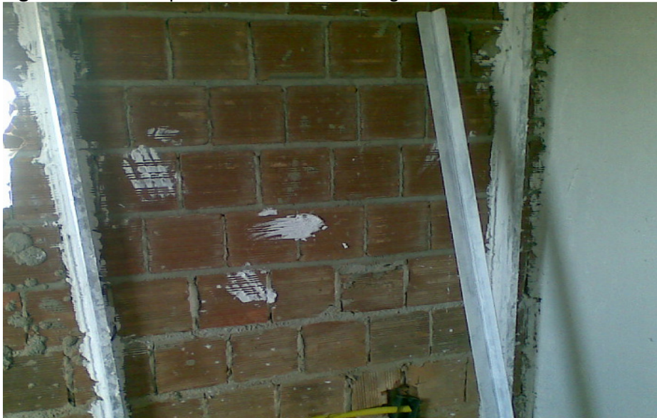
Figura 07. Mestra para o revestimento em gesso.
