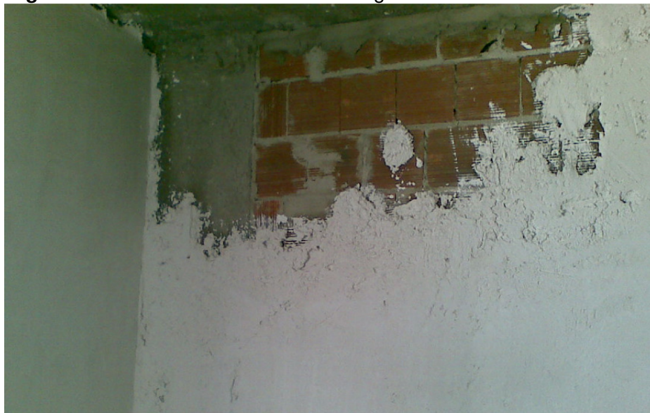
Figura 03. Processo de revestimento de gesso.
