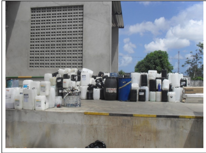
Figura 04 – Área externa da SERQUIP (Galpão para Armazenamento Temporário Pré-incineração) Fonte: A. S. E da Silva, 2012.
