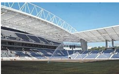
Figura 6 - Cobertura de Estádio triangular
