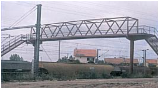
Figura 9 - Passagens aéreas de estrutura triangular .
