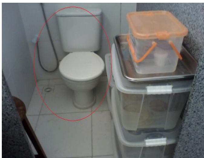
Figura 16: Espaço físico inadequado. Fonte: Dados da pesquisa, 2011.
