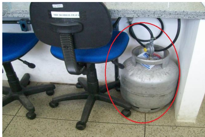
Figura 18: Botijão de gás dentro do laboratório.
