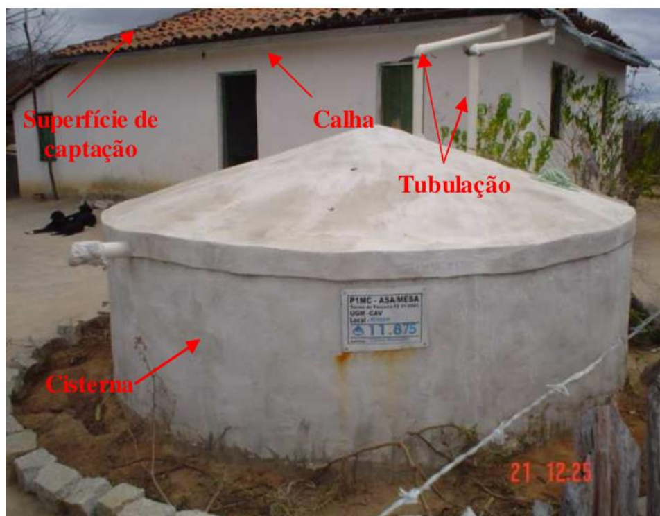
Figura 1 – Sistema de captação e armazenamento de água de chuva baseado em cisterna de placas adotado pelo P1MC.
