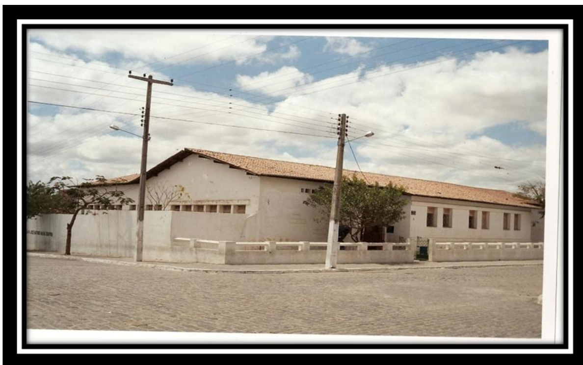
Ilustração1: Fachada do prédio da escola antes da reforma
