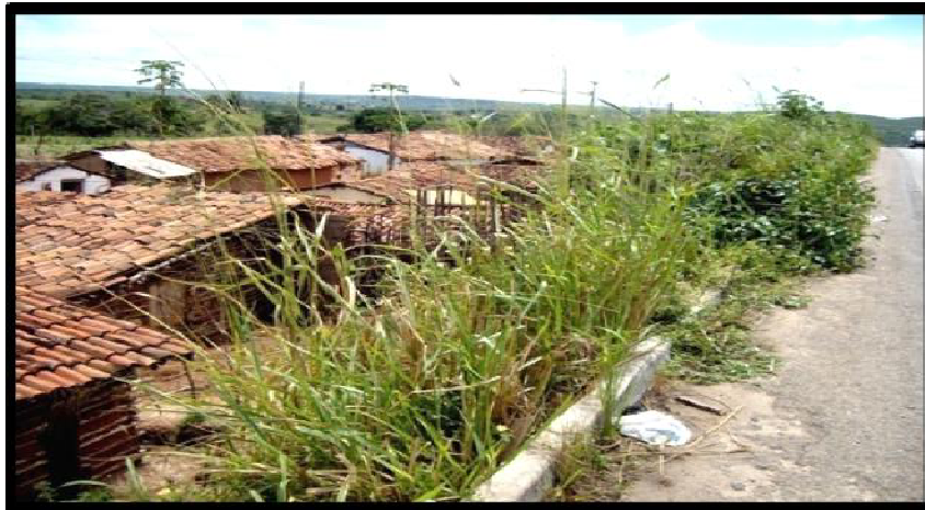
FIGURA 12: Casas da Vila Queimadas próximo à Rodovia PB-105
