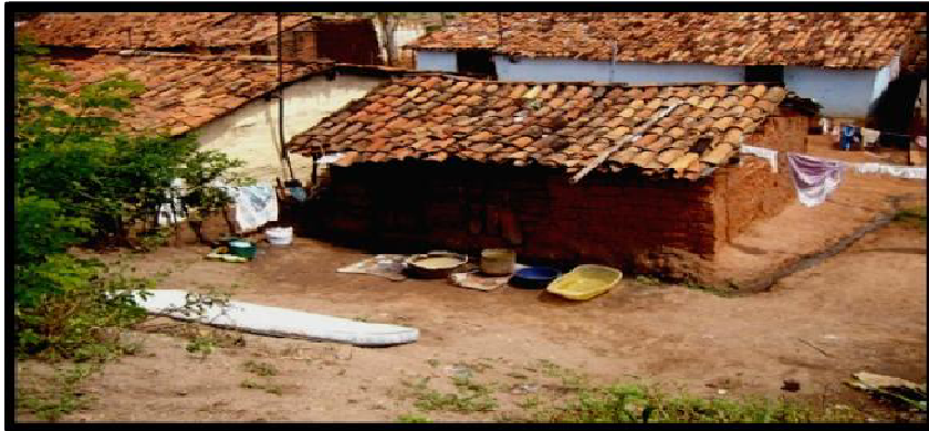
FIGURA 15: Falta de água encanada. Depósitos usados para armazenar água
