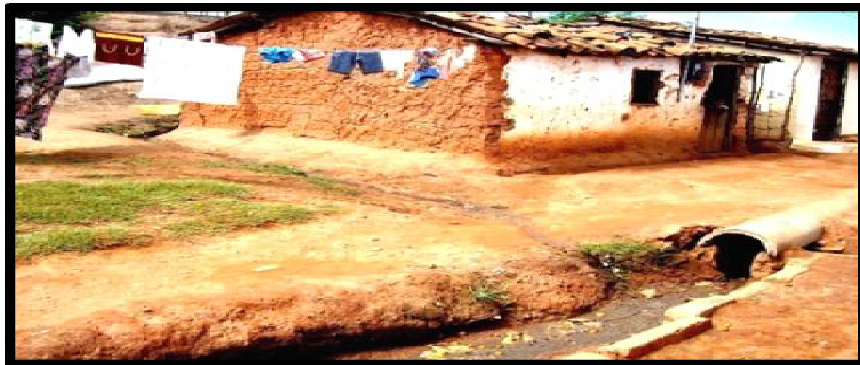
FIGURA 13: Esgoto a céu aberto na Vila Queimadas
