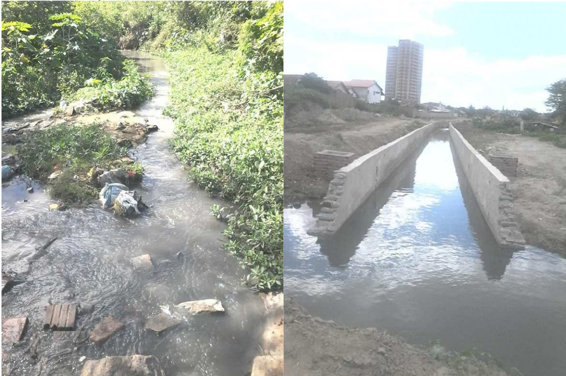
Figura 11: Construção do Canal Novo Cruzeiro /Jardim Paulistano
