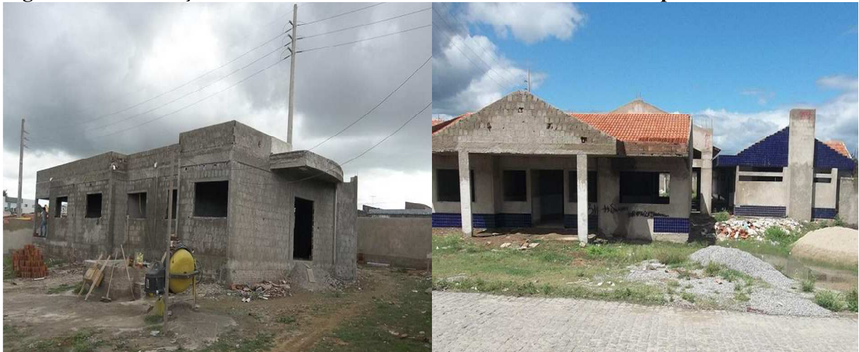
Figura 13: Construções em andamento do CREAS e da Creche municipal
