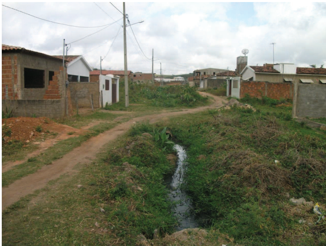
Figura 04: Ausência de infraestrutura na área urbanizada. Acervo pessoal de Fernanda de Melo. Janeiro de 2011.
