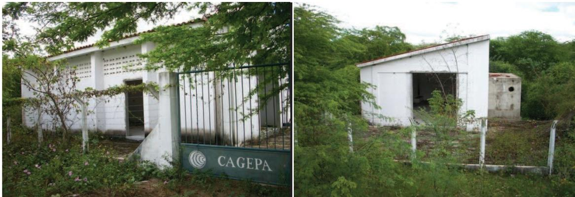
**Figuras 26 e 27: Estação elevatória de bombeamento inacabada à jusante do barramento. Pesquisa de campo, 2011.**
