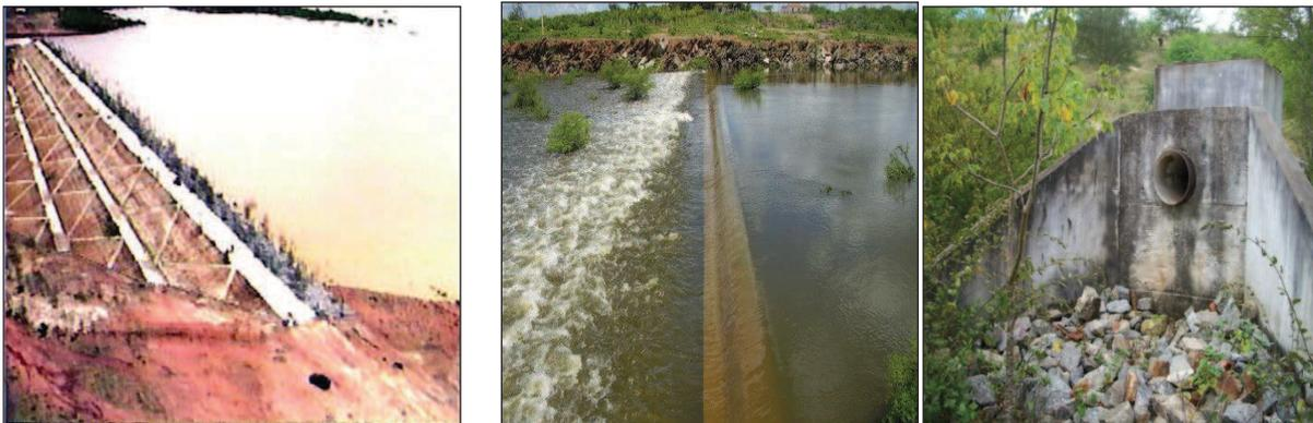
Figuras 07, 08 e 09: Altura, extensão e largura do coroamento; tomada d'água e vertedouro respectivamente. Pesquisa de campo, 2011.
