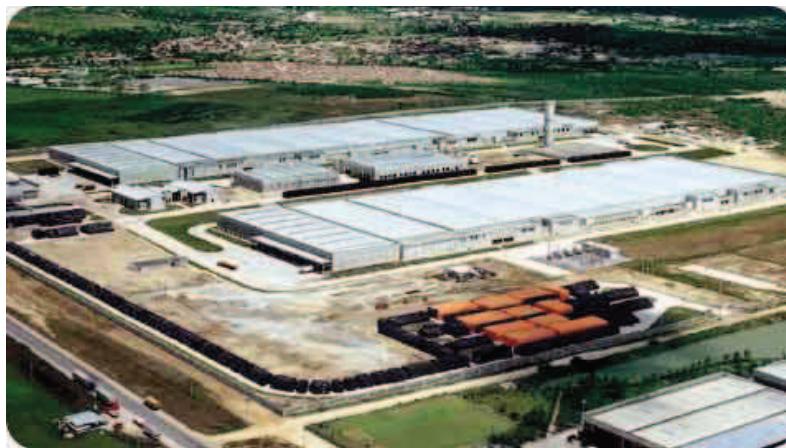
Figura 1: Vista panorâmica da Coteminas.
