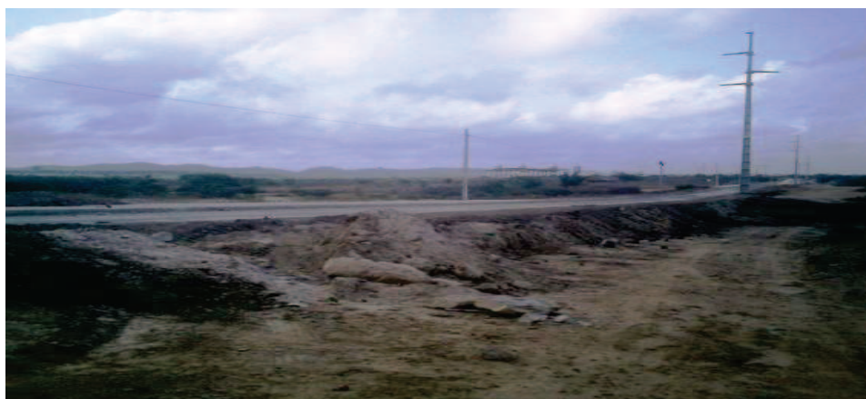
Figura 7: Ajuste espacial: construção da Via de Acesso a UTE. Em pesquisa de campo realizada em Fevereiro de 2011.
