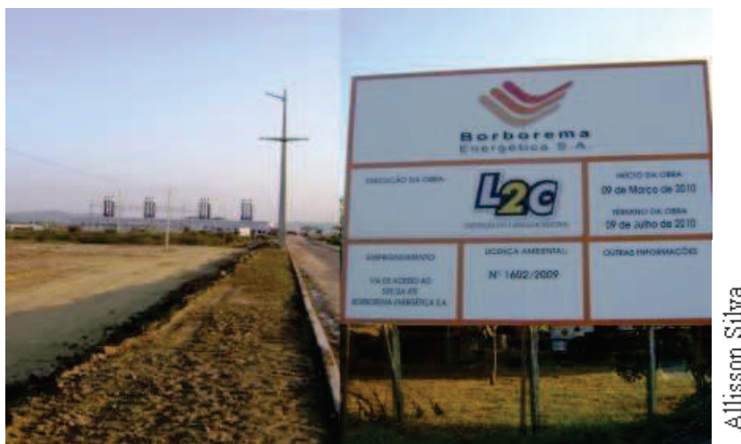
Figura 2: Via de acesso e ao fundo a Usina Termelétrica. Pesquisa de campo. Dezembro de 2010
