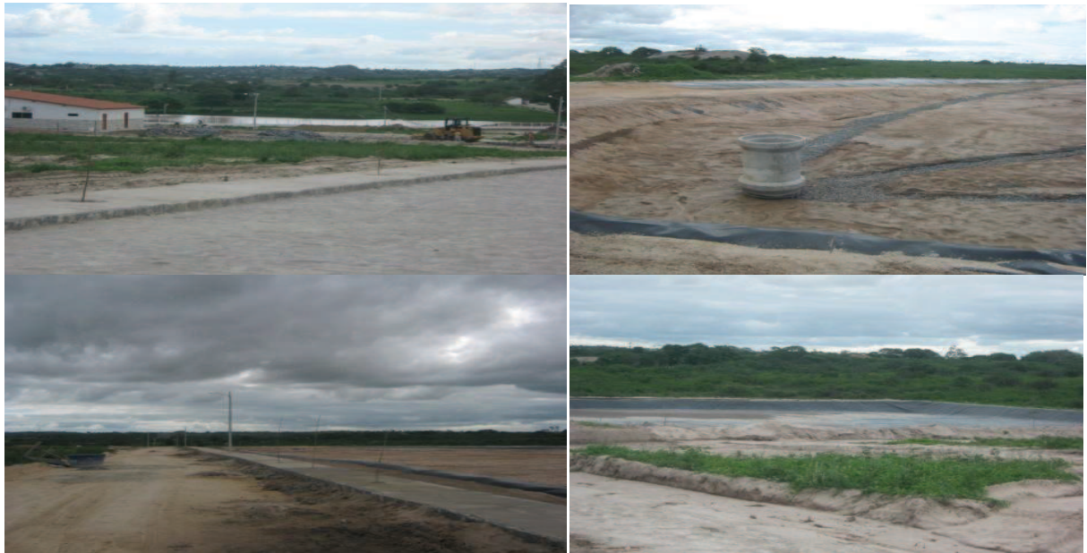
FIGURA 25: Andamento da construção do aterro sanitário FONTE: Pesquisa de campo, 2011
