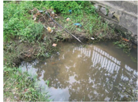
FIGURA 10: Vazamento na rede de esgoto no período chuvoso Açude João Suassuna FONTE: Pesquisa de campo, 2011
