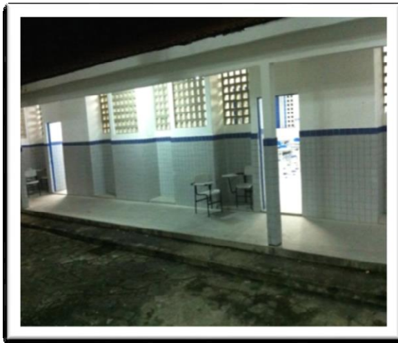
Figura 2 – Corredor das salas de aula Fonte: arquivo pessoal
