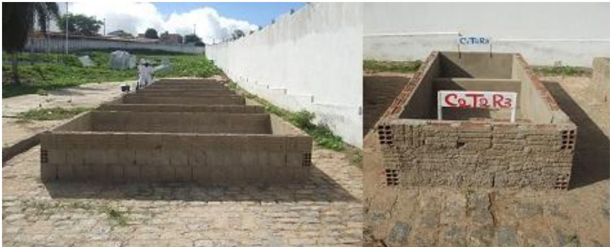
Figura 1 - Foto do Sistema de Tratamento Descentralizado de Resíduos Sólidos Orgânicos Domiciliares. Santa Rosa, Campina Grande-PB, 2010.
