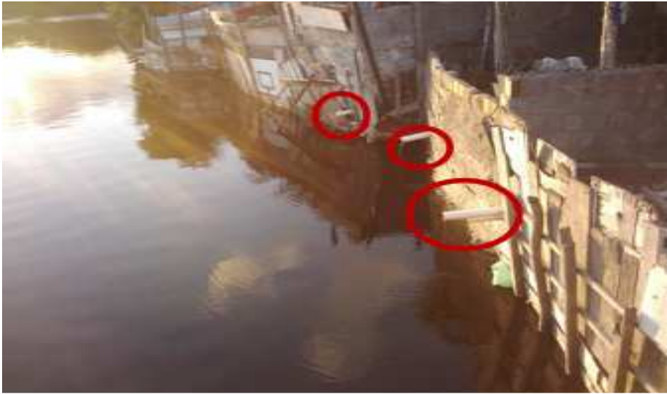
Figura 10- Esgoto diretamente no rio Mandacaru proveniente de algumas casas da Comunidade Salinas Ribamar. Fonte: Gilson Moura.
