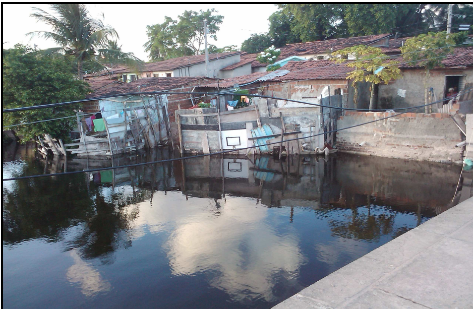
Figura 11- Imagem revelando a situação de precariedade das casas da Comunidade Salinas Ribamar. Fonte: Thalita Lacerda.
