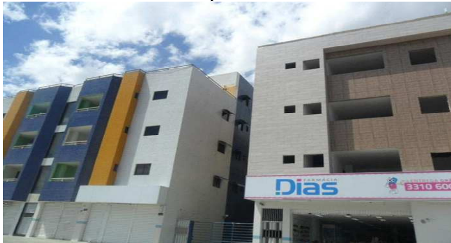
Figura 10: Condomínios residenciais com pontos comerciais no térreo.
