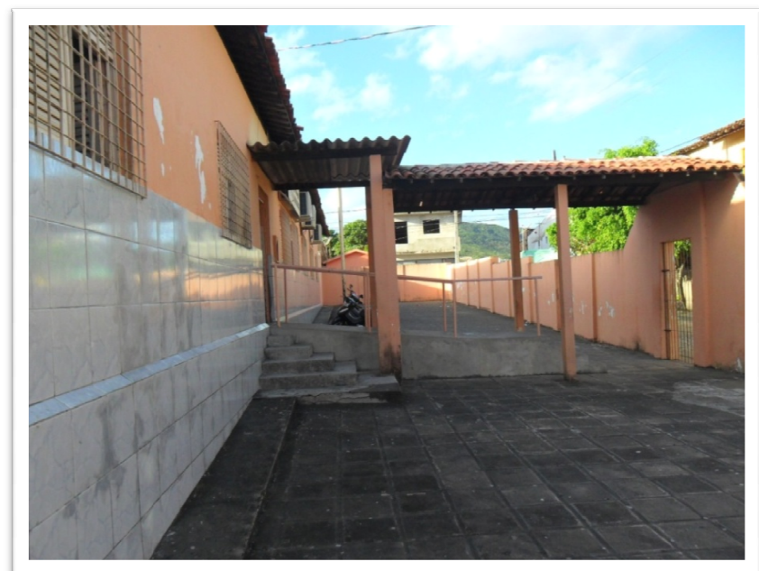
Figura 02 – Parte interna da entrada da E. E. E. F. Dep. Gustavo Amorim da Costa
