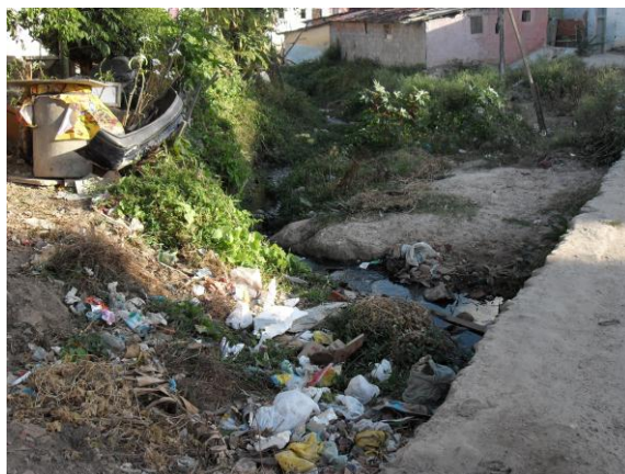
Figura 19. Início do quarto trecho a montante do riacho. Fonte: o autor A imagem historiou o ponto da Avenida Severino Verônico com a Rua Franklin Araújo.
