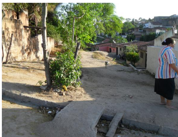
Figura 17. Início do terceiro trecho a montante do riacho. Fonte: o autor
