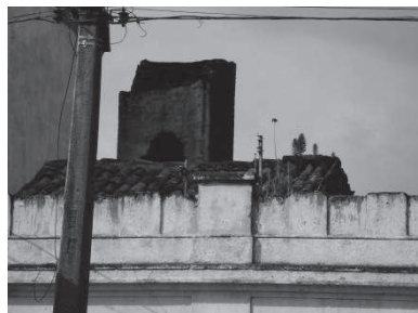
Figura 5 – Detalhe da chaminé da antiga usina de luz
