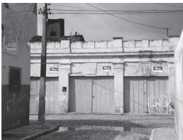
Figura 4 – Vista total da antiga usina de luz
