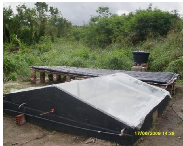
Figura 1: Caixa de alvenaria para evaporação/condensação da água após o aquecimento no coletor solar
