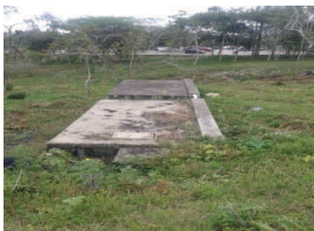
Figura 19 - Sistema de tratamento dos efluentes do CCT.
