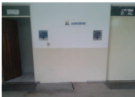
Figura 12 - Parte externa do banheiro.
