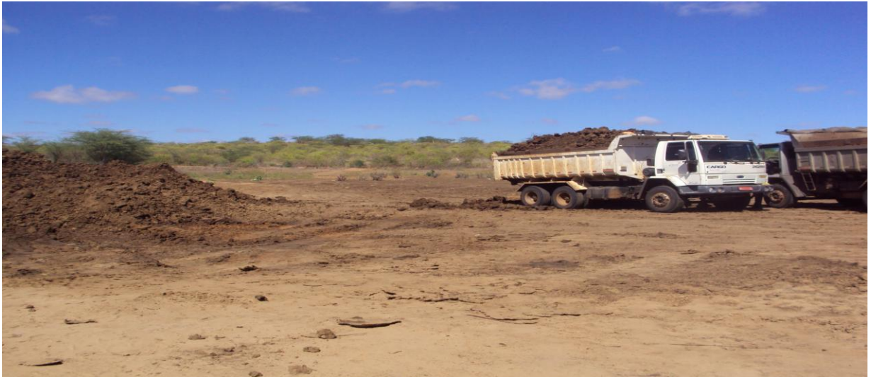
Figura 05: Carregamento das caçambas de argila
