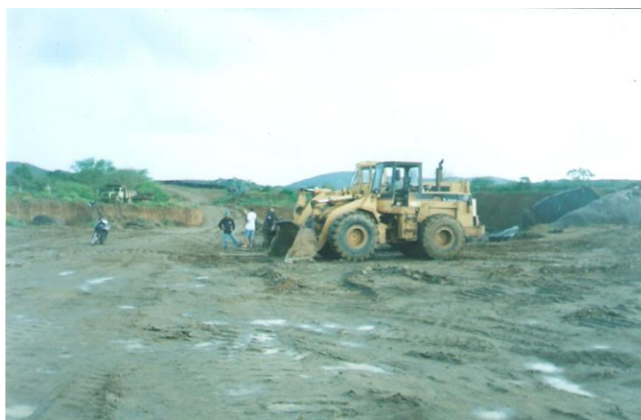
FIGURA09: Homens trabalhando sem equipamentos de segurança.
