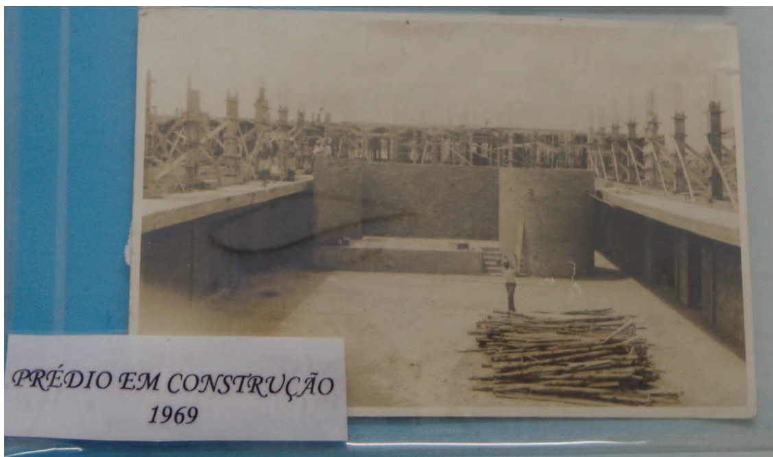
Prédio em construção: 1969
