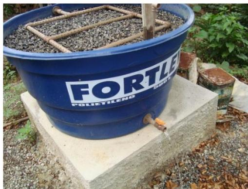
Essa tubulação inferior está conectada ao cano que atravessa verticalmente todas as camadas internas do filtro chegando até 10 cm acima da superfície, com a finalidade de aerar a porção inferior do filtro (Figura 10).
