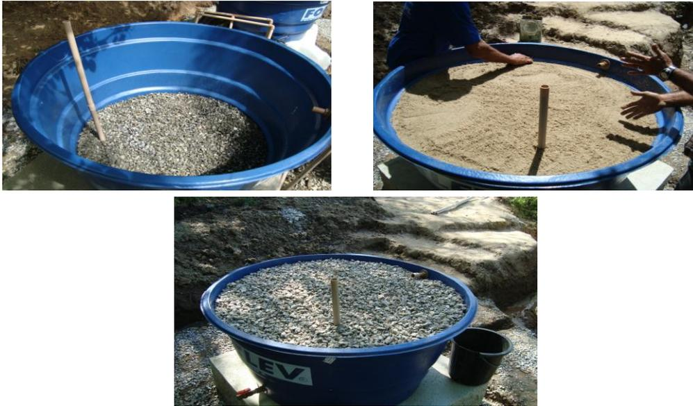
No fundo, sobreposta pela camada de brita N° 03 se instalou uma estrutura de canos, similar a da parte superior, que drena o efluente para fora do filtro aeróbio por meio de uma extremidade, esse dreno se constitui em uma “torneira” em cada filtro, situada na base das caixas (dos filtros) (Figura 9).
