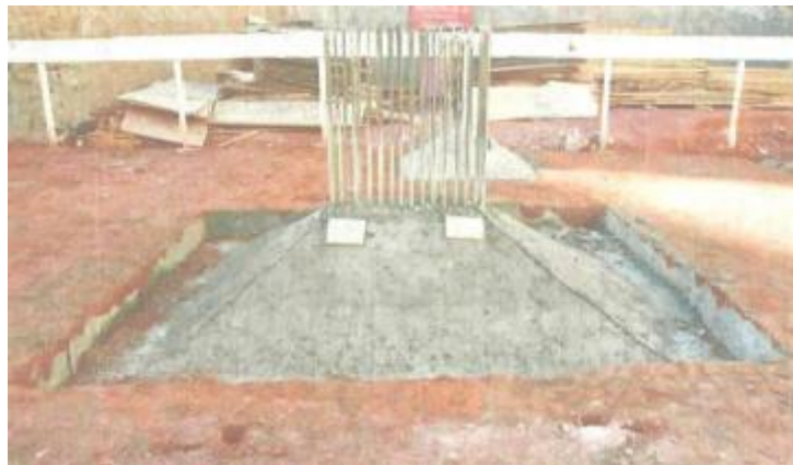
Figura 2 - Execução de sapata.
