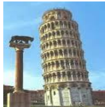
Figura 21 – Recalque Torre de Pisa.
