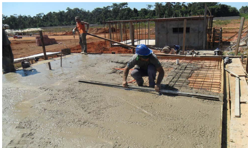
Figura 18 – Concretagem da laje maciça.
