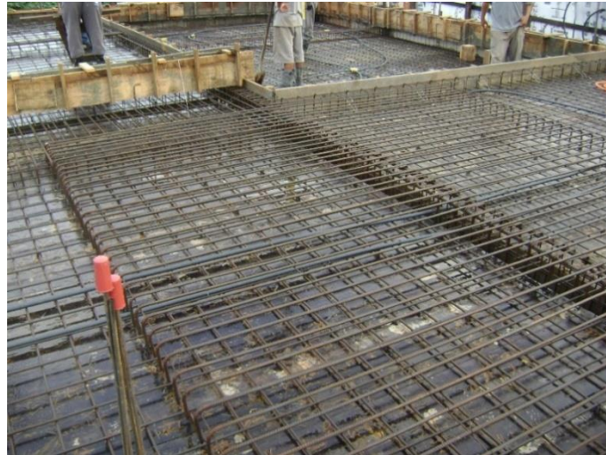
Figura 17 – Armaduras transversais e longitudinais da laje maciça.
