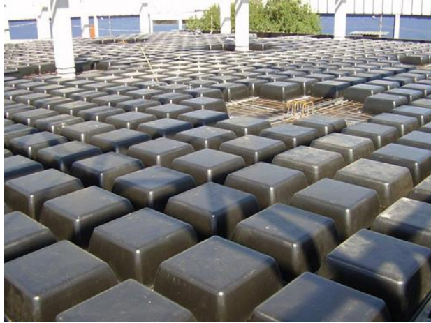
Figura 10 – matérias inertes e a fôrmas.
