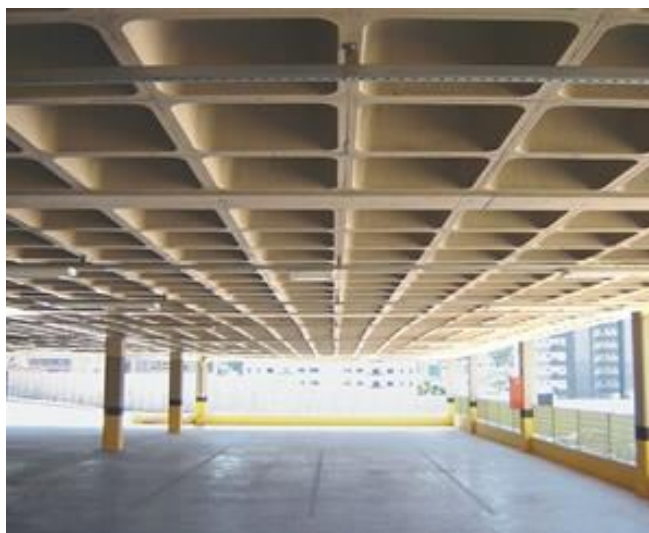
Figura 12 – Aspecto final da laje nervurada.
