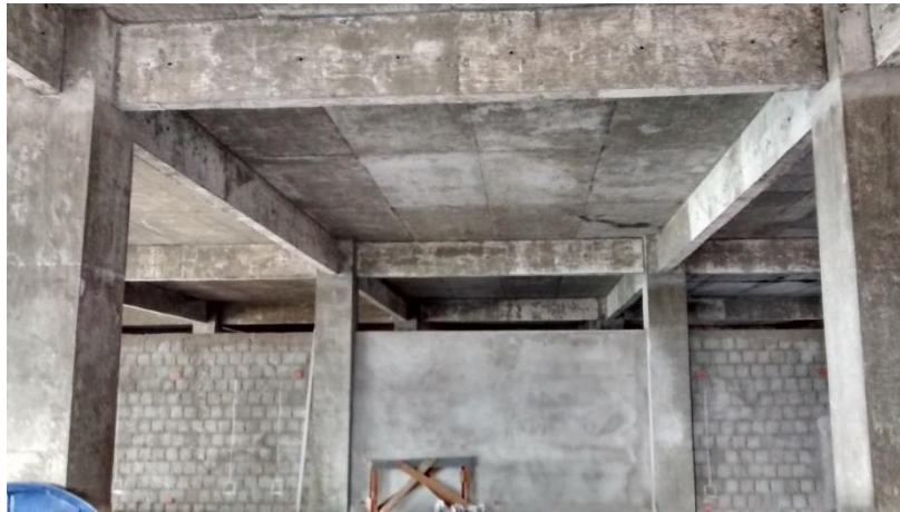
Figura 19 – Aspecto final da laje maciça – Obra TRT, João Pessoa –PB.
