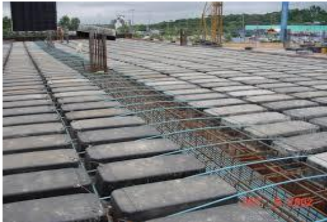
Figura 11 – Disposição do aço na laje nervurada.
