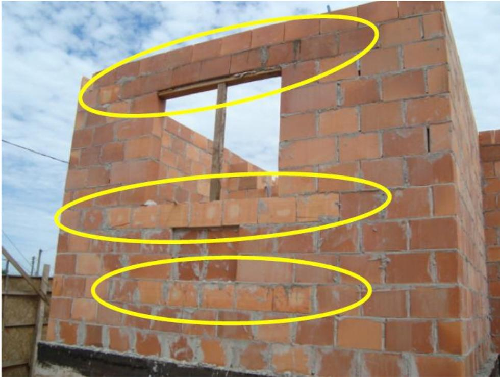
Figura 13 – Vergas e contravergas com bloco canaleta
