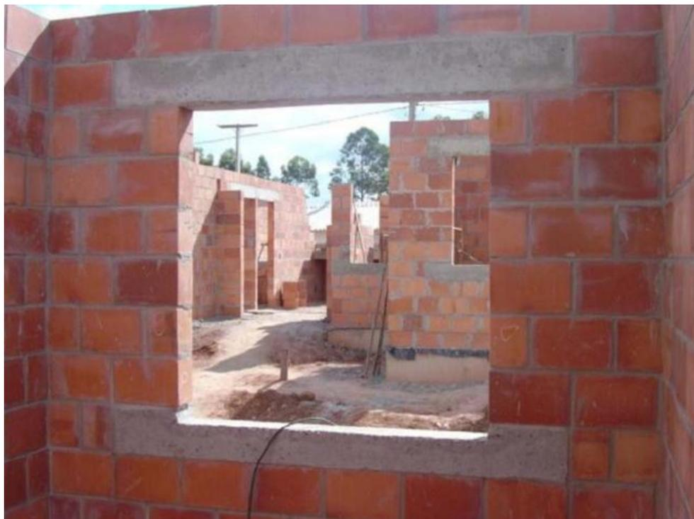
Figura 15 – Verga e contraverga pré-fabricada de concreto.
