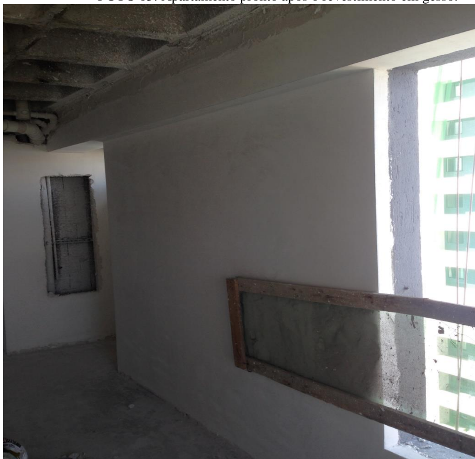
FOTO 05: Apartamento pronto após o revestimento em gesso.
