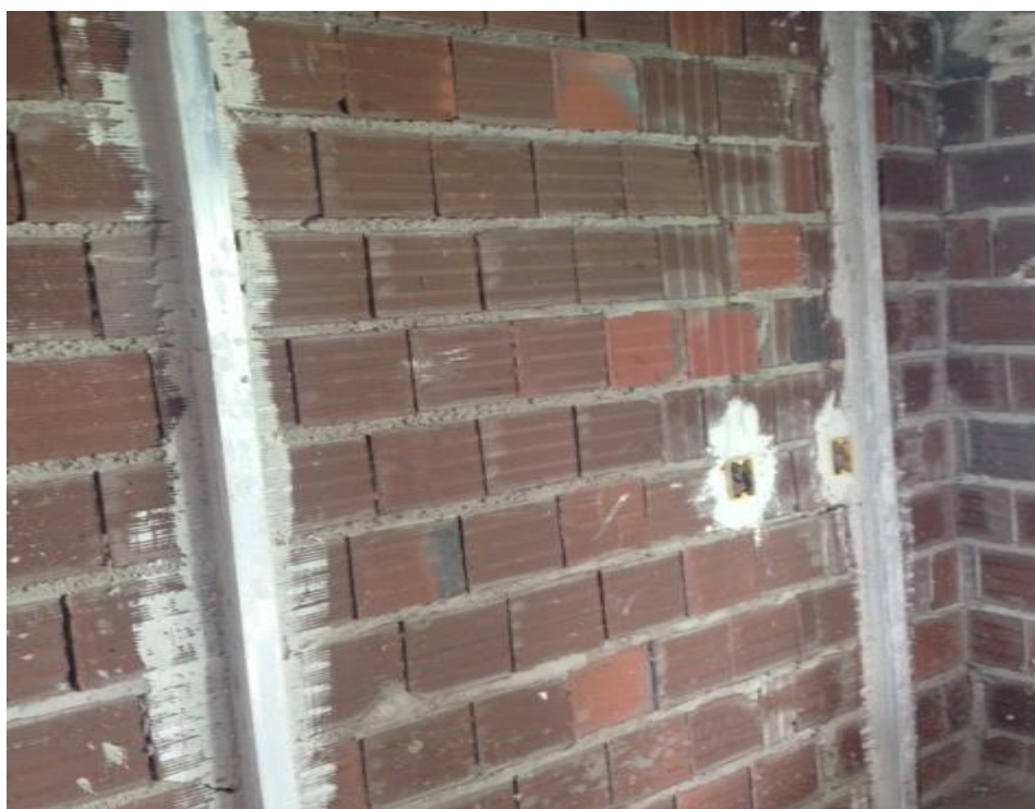
FOTO 02: Colocação de taliscas
