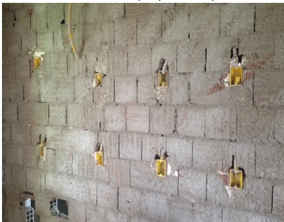
FOTO 03: Parede após o processo de chapisco
