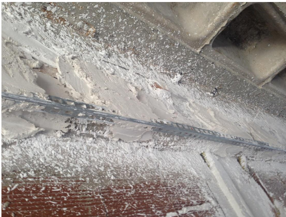
FOTO 04: Utilização de cantoneiras.
