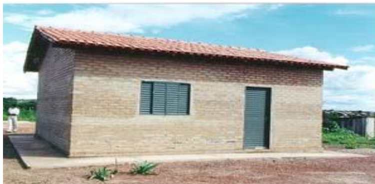
Figura 1 - Casa popular construída com tijolo solo-cimento na cidade Cuiabá- MT
