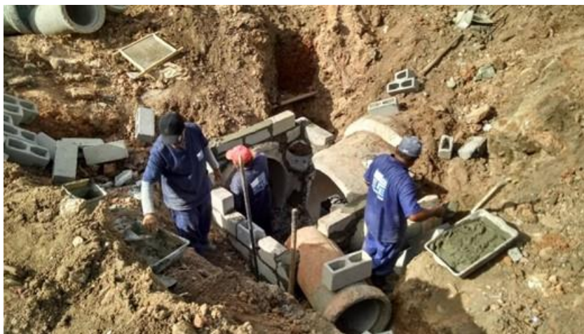
Figura 3 – Execução de um poço de visita e de suas ligações com os tubos de concreto armado. Fonte: Arquivo pessoal, 2015.
