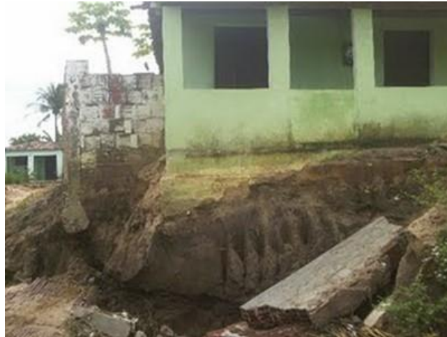
Figura 5 – Habitação com exposição de sua fundação, pondo em risco os habitantes. Fonte: Adaptado de Blog do Mago, 2013.
