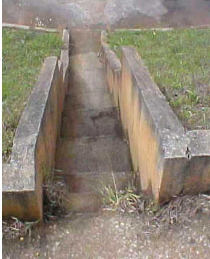
Figura 06: Descida d'água executada.
