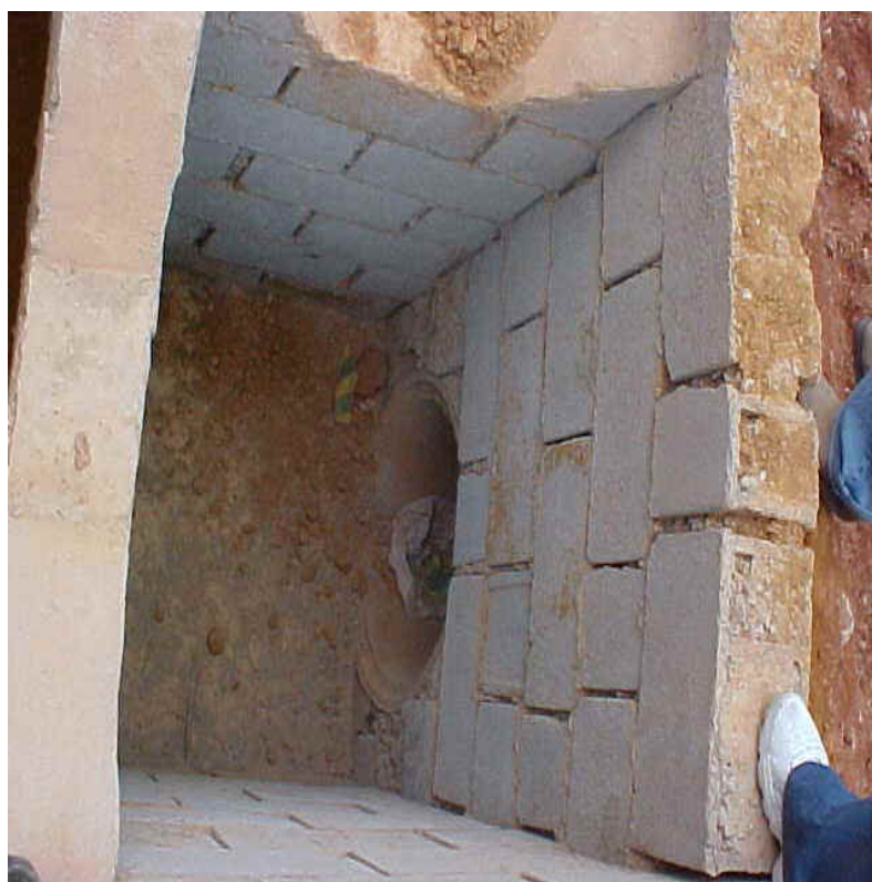
Figura 08: Caixa coletora executada.
