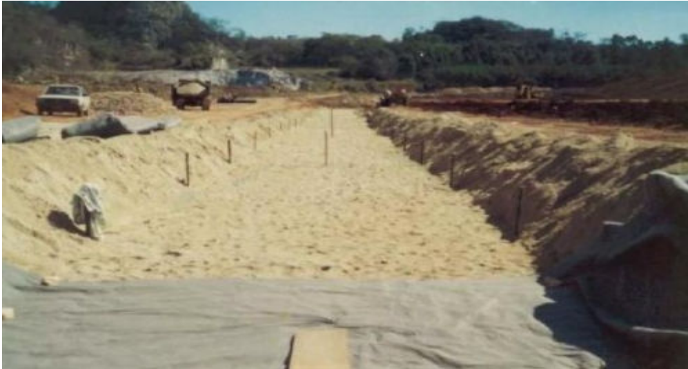
Figura 18: Colchão drenante sendo executado.
