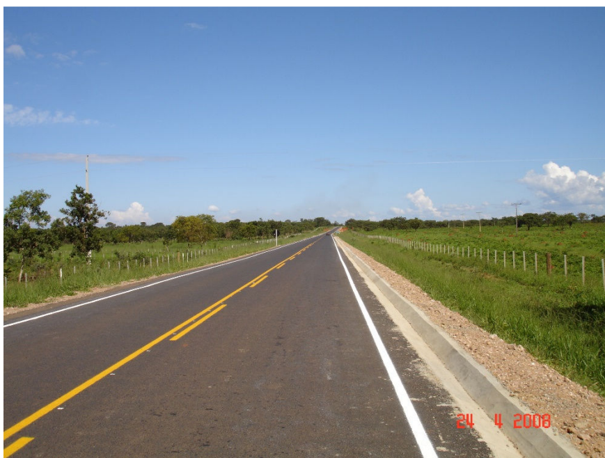
Figura 03: Exemplo de sarjeta triangular executada (lado direito do pavimento).
