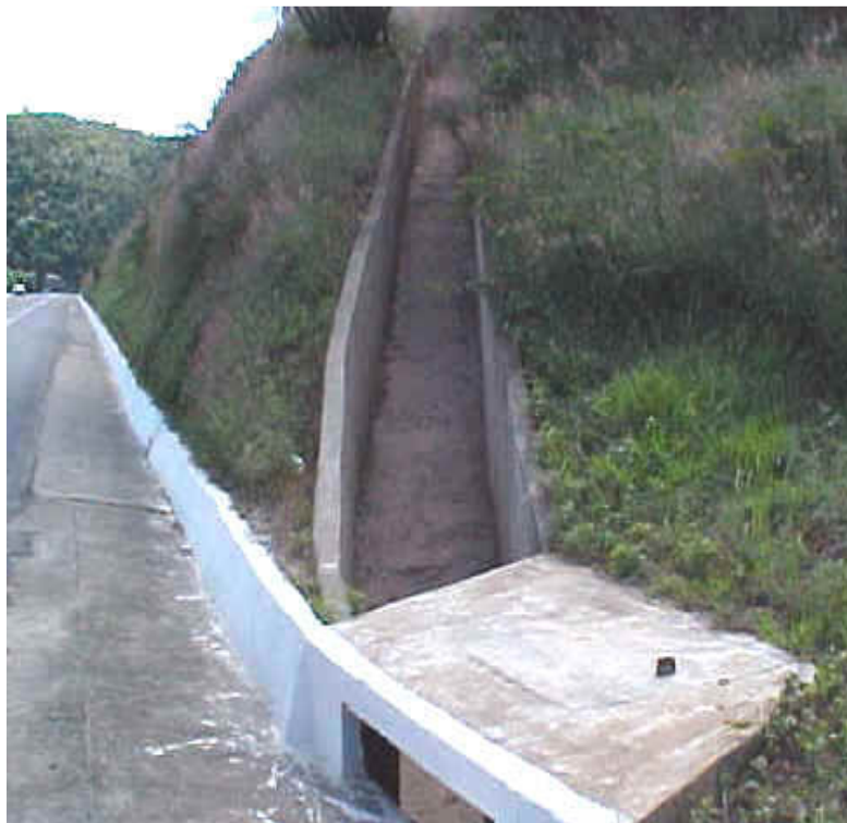
Figura 02: Valeta de proteção de corte.
