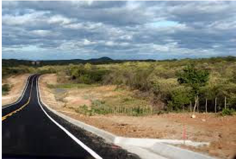
Figura 09: Sarjeta de banquetas executada.
