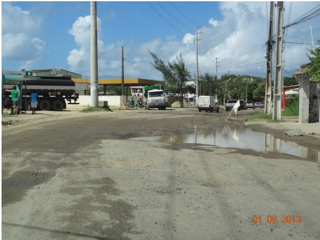
Foto 07: Acúmulo de água devido a inexistência de drenagem
