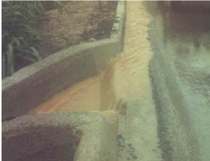
Figura 04: Exemplo de saída d'água executada.
