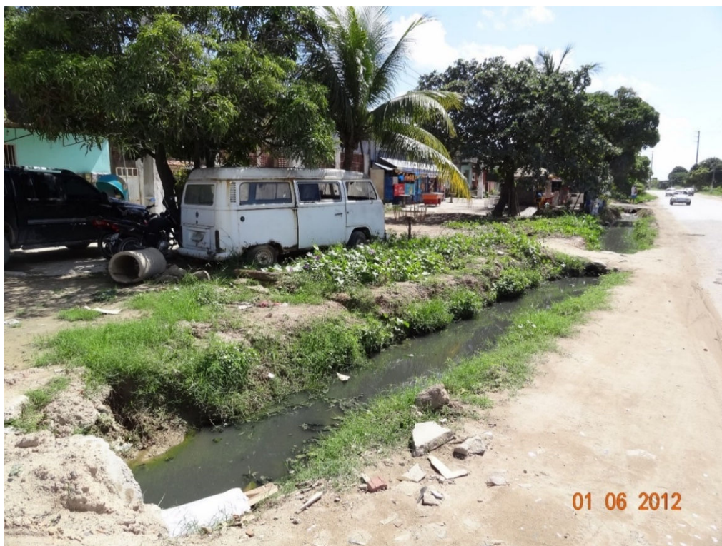
Foto 02: Acúmulo de água devido ao subdimensionamento da drenagem e falta de manutenção.
