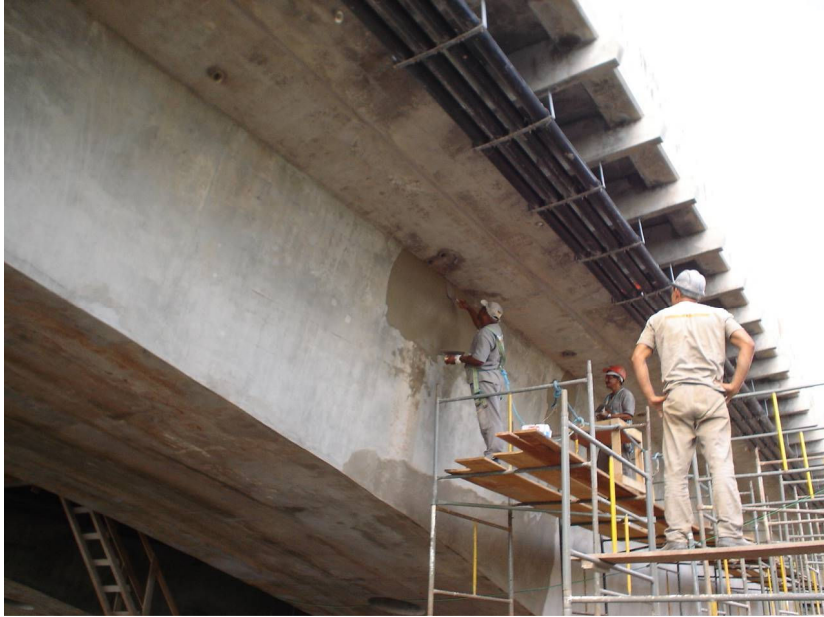
Figura 13 – Recuperação dos dispositivos de drenagem.
