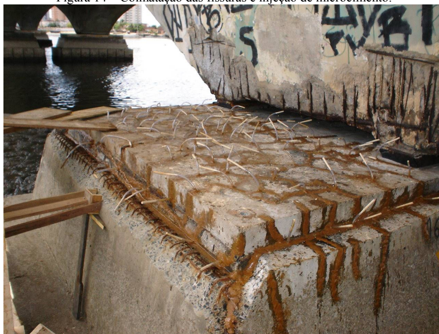
Figura 14 – Colmatação das fissuras e injeção de microcimento.
