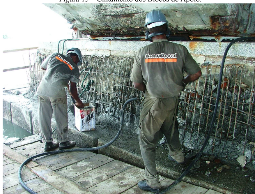
Figura 15 – Cintamento dos Blocos de Apoio.
