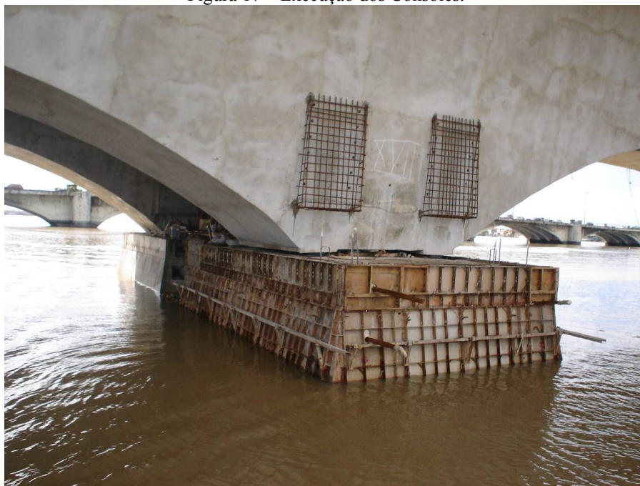
Figura 17 – Execução dos Consoles.
