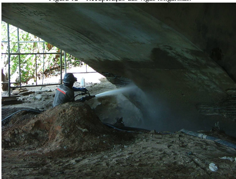
Figura 12 – Recuperação das vigas longarinas.
