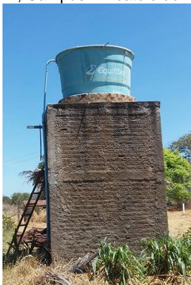
Figura 3- Caixa de distribuição de água, utilizando energia gravitacional para a irrigação do coqueiro, UEPB, Campus IV- catolé do Rocha-PB.
